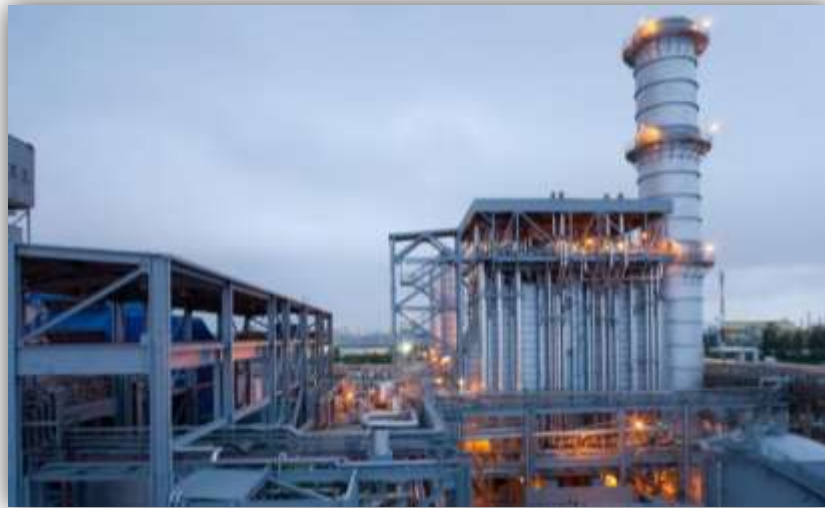
Figura 1 Planta térmica de ciclo combinado
