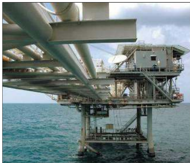
Imagen 1: Plataforma de Chevron en Campo Chuchupa, Guajira
